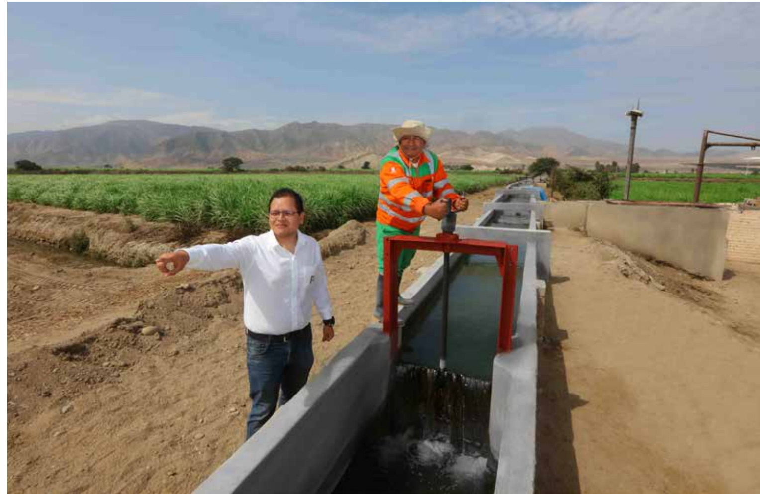
Rehabilitación del canal Canaval después del desborde del río Fortaleza debido al ciclón Yaku.
